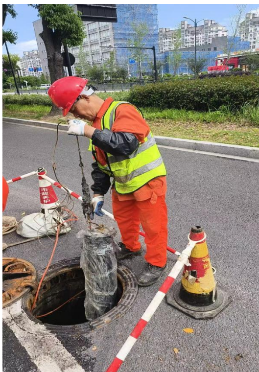
DN300 气囊封拆后
