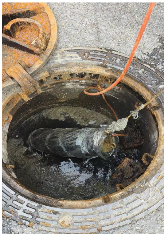
DN300 气囊封堵前
